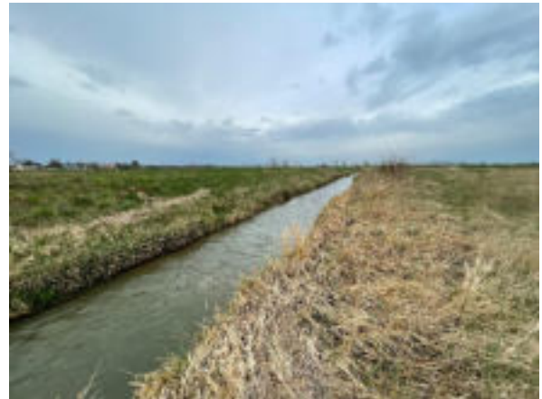
10. ábra: A Keszeg-ér a Beledet Vásárosfaluvá összekötő 8612 sz. út vasbeton hídja mellől Észak-Nyugat felé nézve
