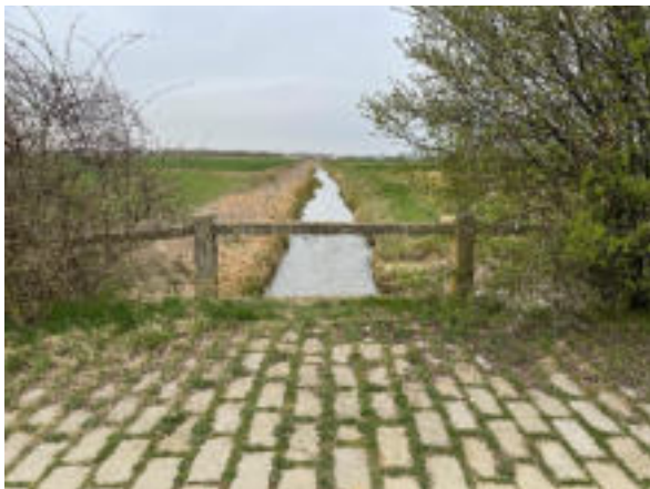
11. ábra: A Keszeg-ér Dél-Nyugat felé nézve a dűlő úti vasbeton hídról (41+616 km)
