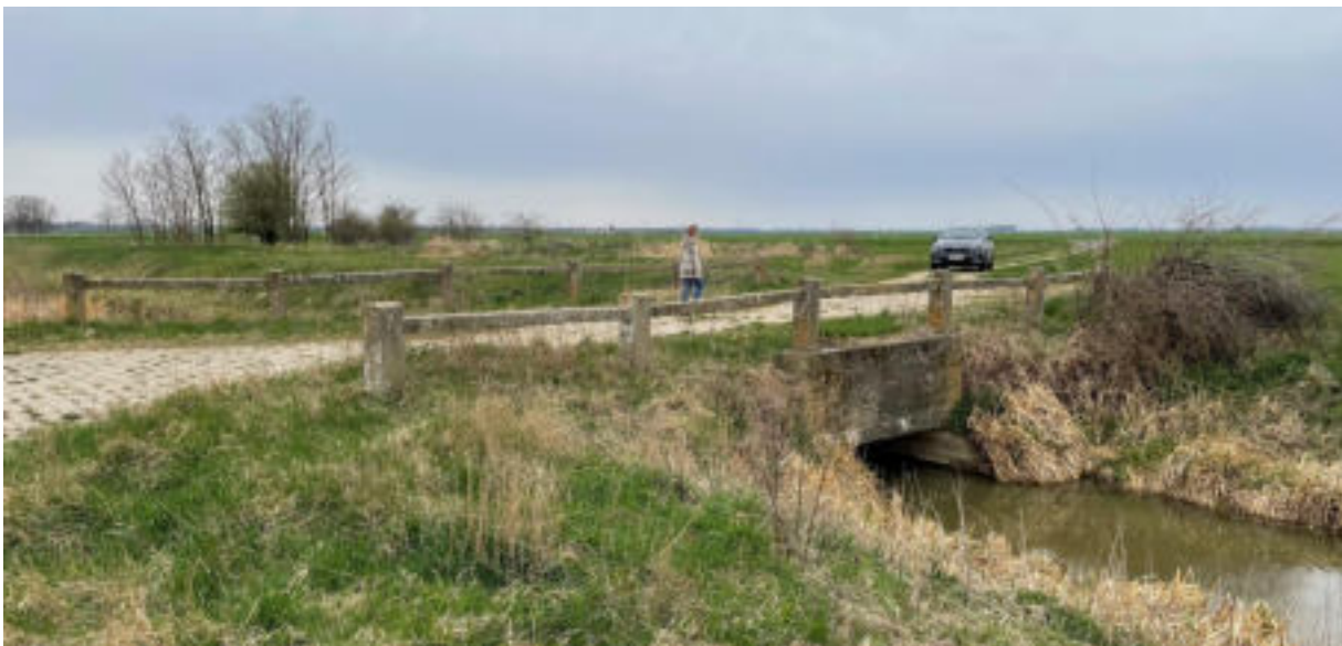
17. ábra: Dűlő úti vasbeton híd (40+194 km)
