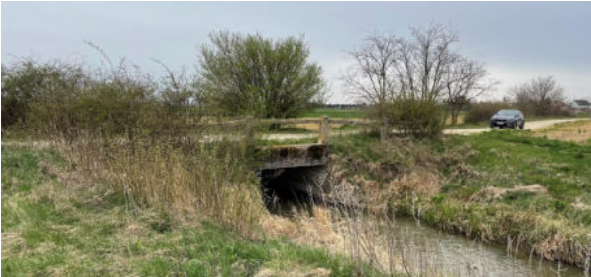
16. ábra: Dűlő úti vasbeton híd (41+616 km)
