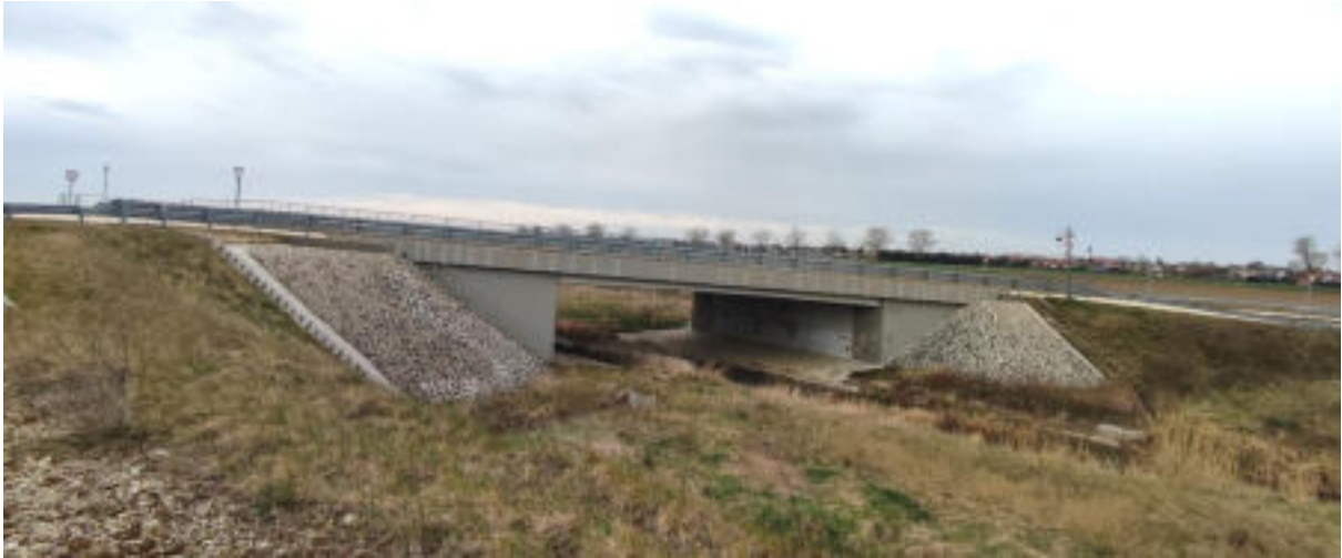
15. ábra: a Beledet Vásárosfaluvval összekötő 8612 sz. út vasbeton hídja (42+120 km)
